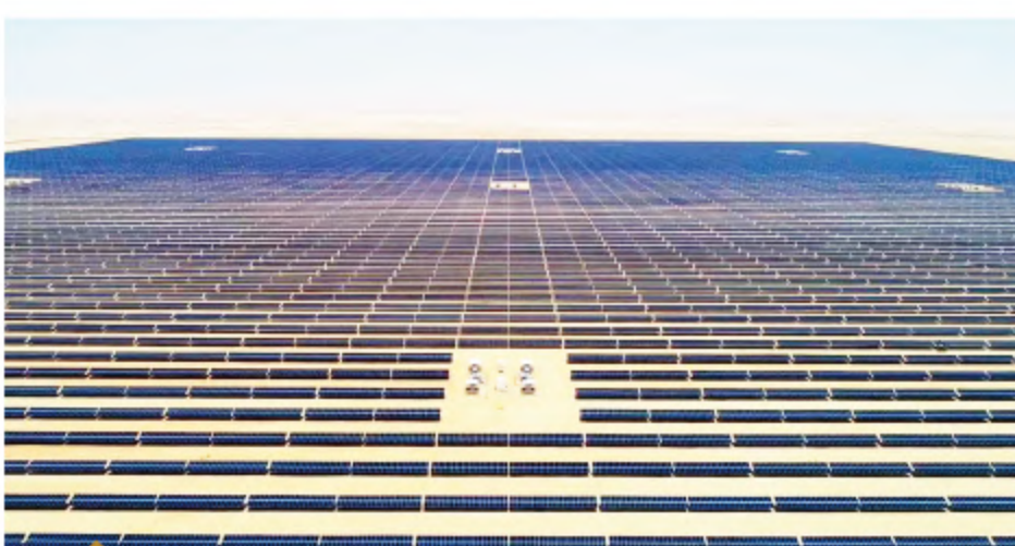
阿曼光伏跟踪项目 PV tracking project in Oman
